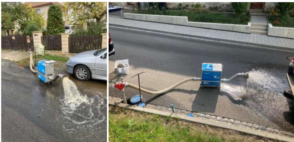
Obr. 1 Čištění vodovodního potrubí – proplach přes hydrant
